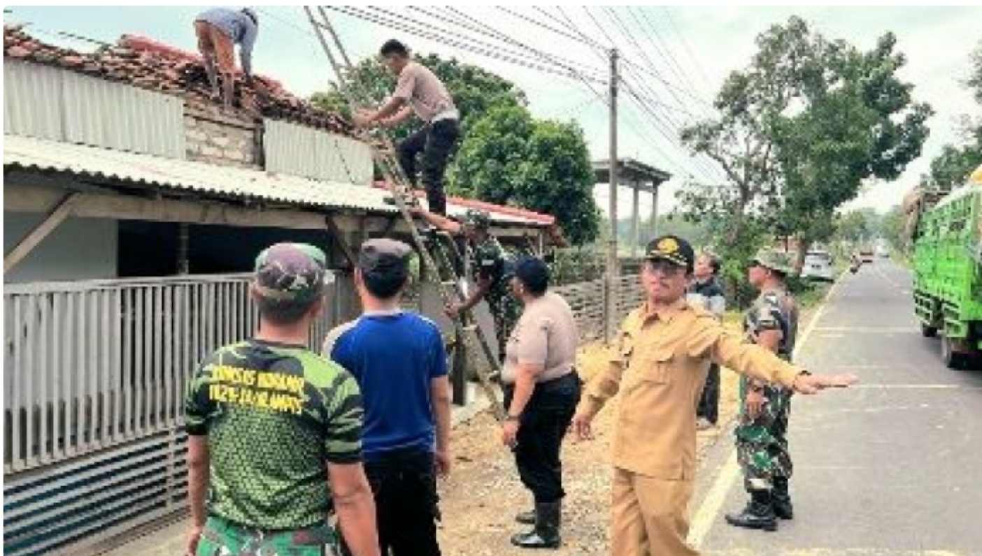
Karya Bakti perbaikan rumah terdampak robohnya tiang listrik.
