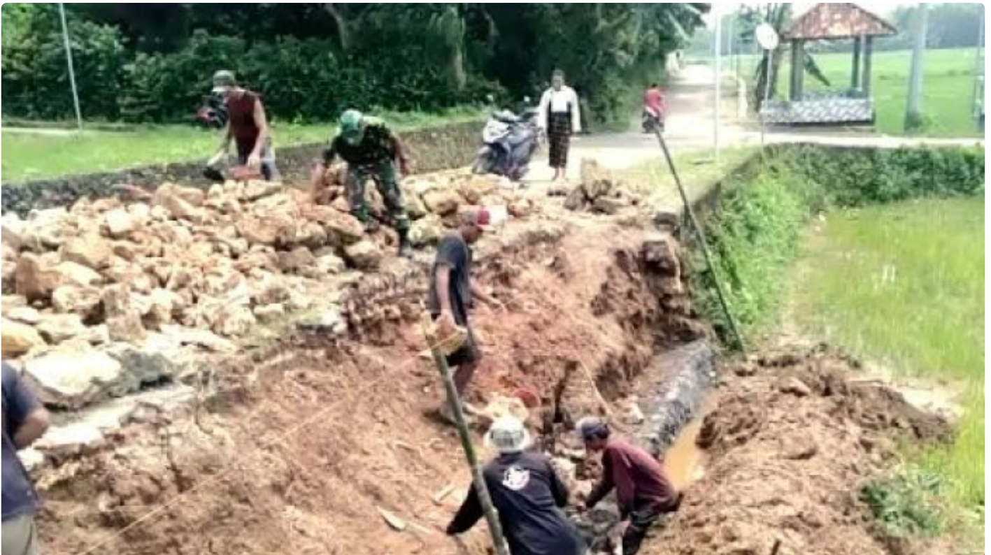
Karya Bakti pembuatan plengsengan penahan jalan
